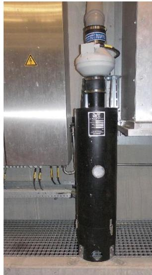
Durch die einfache Systematik lässt sich der Rohrfilter leicht, kostengünstig und effektiv installieren und betreiben. Das System ist ohne Regelung und auch ohne Strom als passives Filtersystem einsetzbar.
