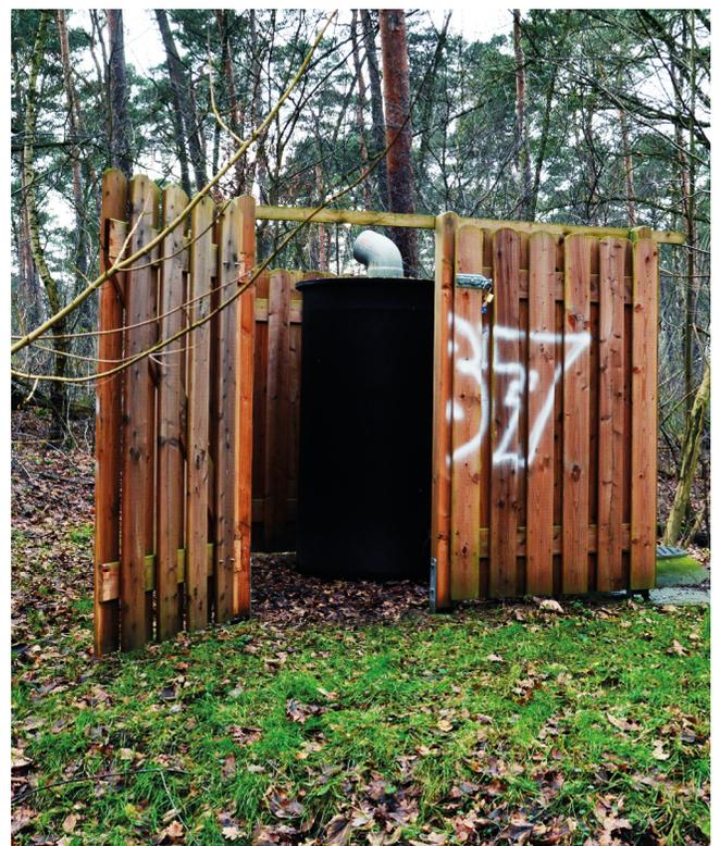
Neben der H<sub>2</sub>S Adsorption konnte durch den Einsatz des SP Mediums die sogenannten Sommergerüche ebenso effektiv gefiltert werden. Vor allem die vorhandene Restfeuchte der Abluft an den Entspannungsventilen hat keinen Einfluss auf die Effektivität des Filters, da das Medium bis zu 99% relative Luftfeuchtigkeit toleriert.
